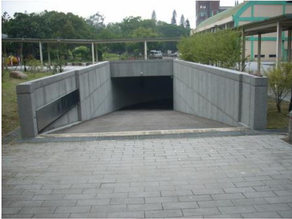
地下停車場入口
